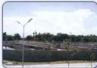
บ่อเติมอากาศแบบคลองวนเวียน
