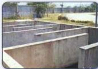
บ่อเติมคลอรีน
