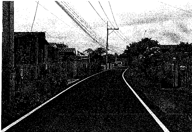
โครงการซ่อมแซมผิวจราจร คสล.โดยการเสริมผิวลาดยางแอสฟัลท์ติกส์คอนกรีต (โอเวอร์เลย์)
